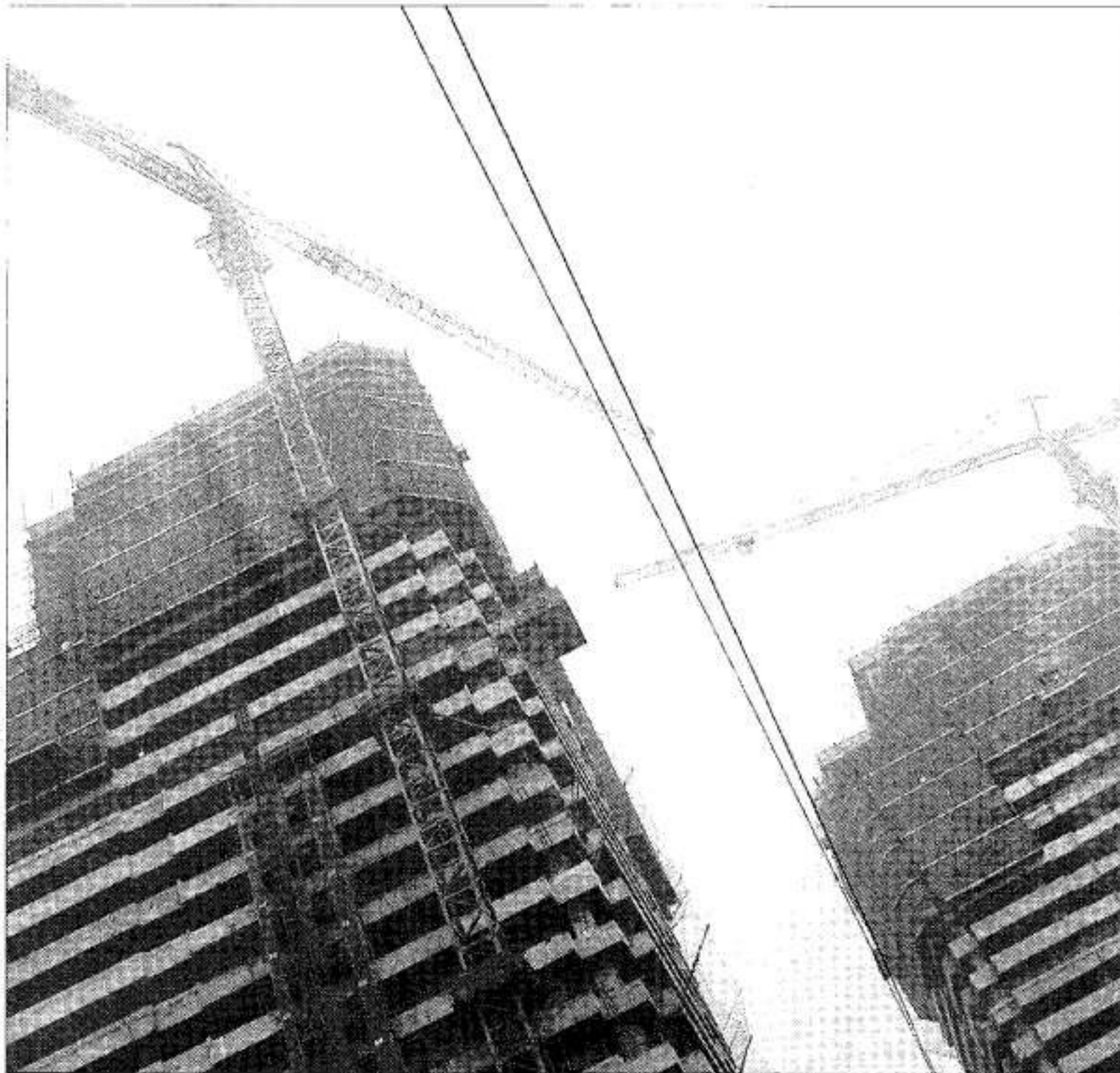
Symbol für den Bauboom. Überall schießen Hochhäuser aus der Großstadterde – sei es in Peking (Foto), Chengdu oder auch Deyang.
